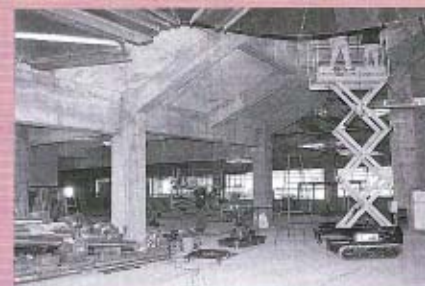
内部工事の様子
