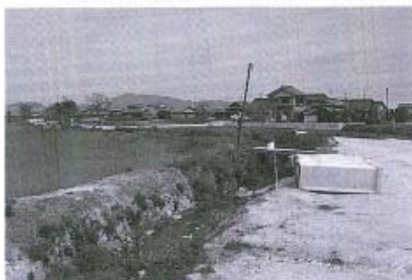
新館川での災害改良復旧事業（施工前）
