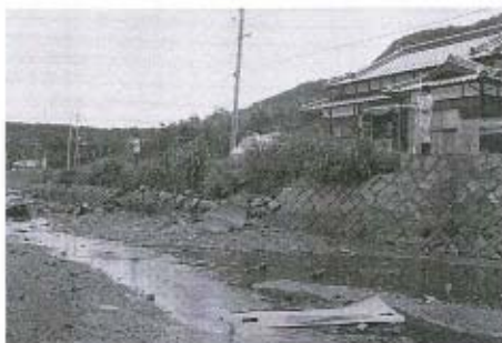
町道小浜線災害復旧事業（施工前）
