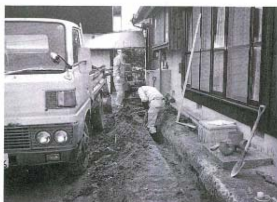
宅内配管工事（秋穂西地区）
