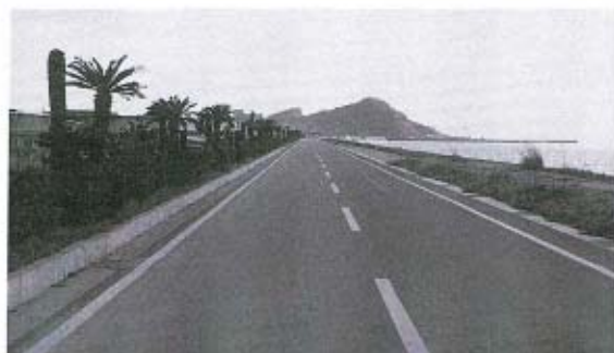
整備が進む漁港関連道
