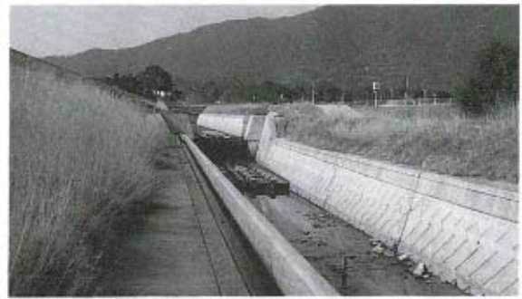
改修された新館川
