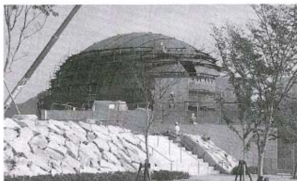
●工事の進む大海総合センター
