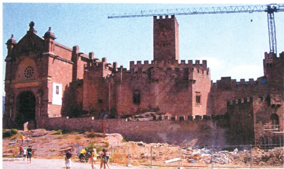
生誕500年祭に向けて工事が進むサビエル城
