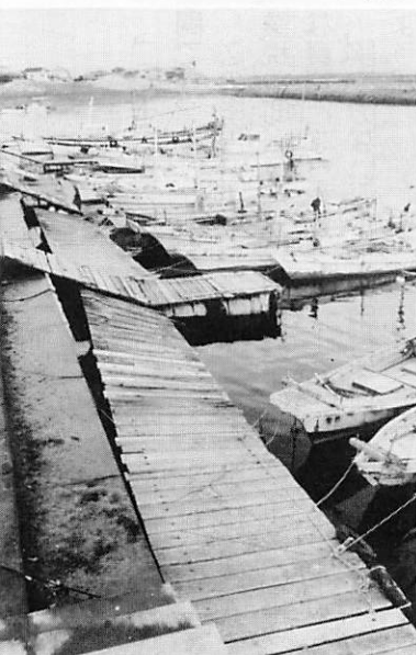
▲漁港改修事業…船着場が完成
