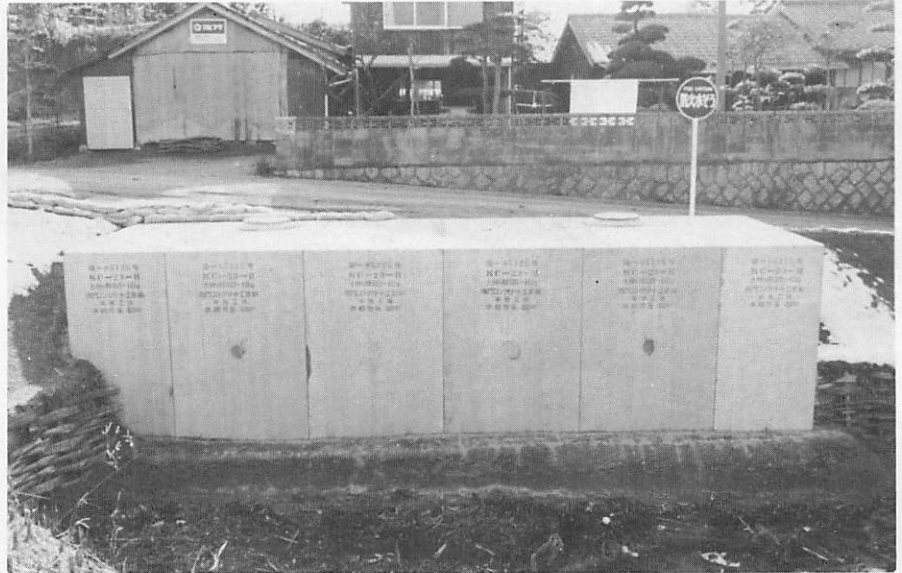
② ▲向井関防火水槽
