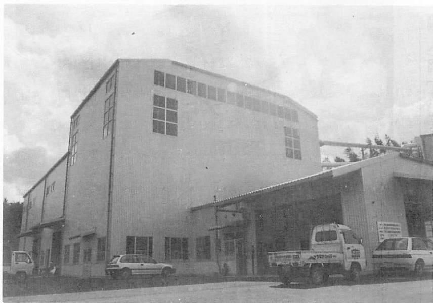
▲完成したライスセンター本棟
