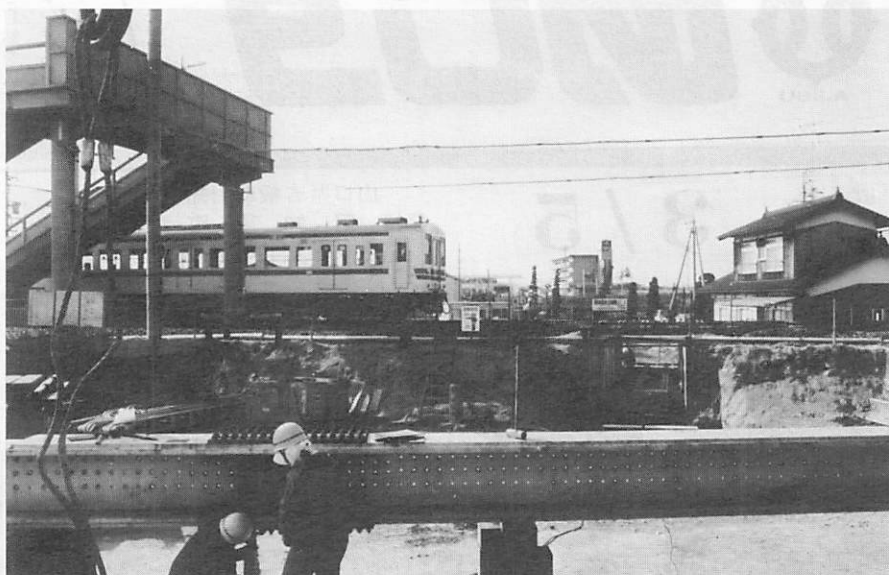
①▲工事が進む駅地下道
