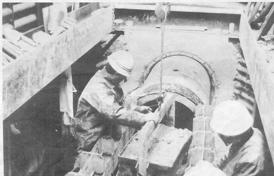
③▲下水道管の布設工事(同仁病前)
