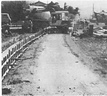
⑤ 工事中の杖川道路
