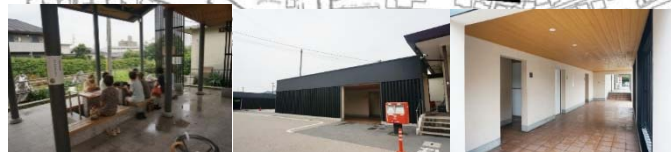
湯田温泉駅足湯、公衆トイレ整備
