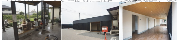
湯田温泉駅足湯、公衆トイレ整備
