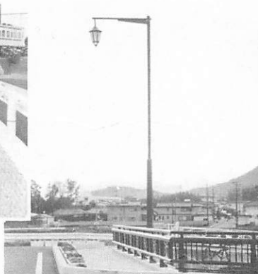
◀浜表バス停そばの井関川浜表橋の改修工事完成(6月)
