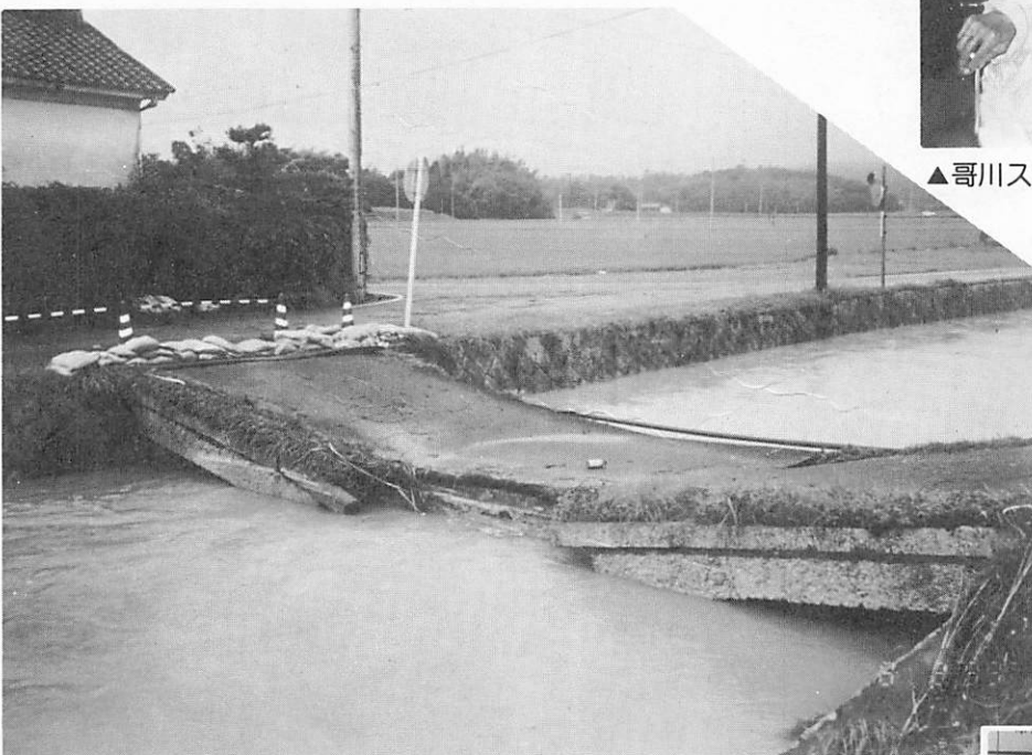
▲8月2日に停滞前線がもたらした豪雨で、本町でも多大な被害(被害額約6千6百万円：写真は決壊した井関橋)
