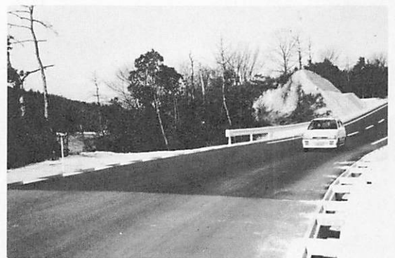
▶西岐波野口線 道路改良
