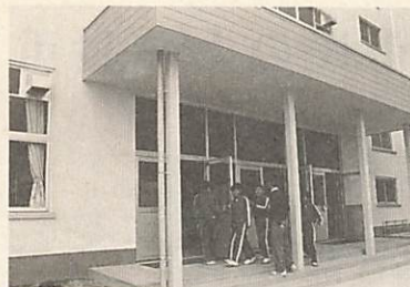
築後40年の白石中学校で外壁改修と 出入口を新設
