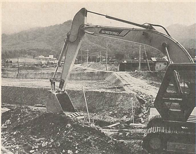
農地の汎用化や高度利用を図り、近代的な農業を営むためには場整備事業が進められています。3年度末実施計画面積は1,121haで、全体計画面積の47%となっています。(写真は仁保下郷地区)
