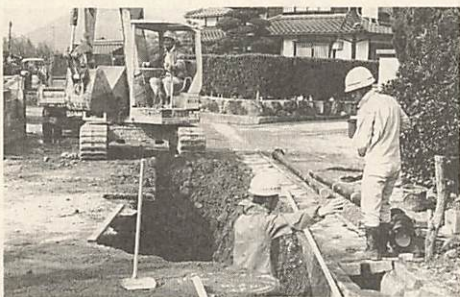
公共下水事業の本管工事(折本二丁目)
