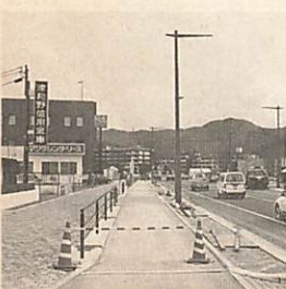
工事が進む山大通り
