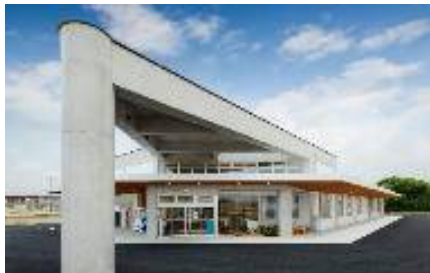
佐山地域交流センター(R1建設)
