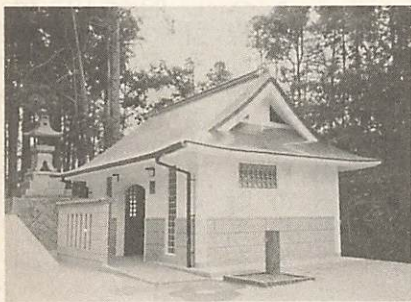
8月1日から使用開始した社風の公衆便所
