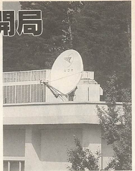
市役所議会棟屋上に設置されたアンテナ
