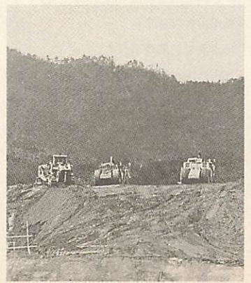
造成工事がすすむ建設予定地
