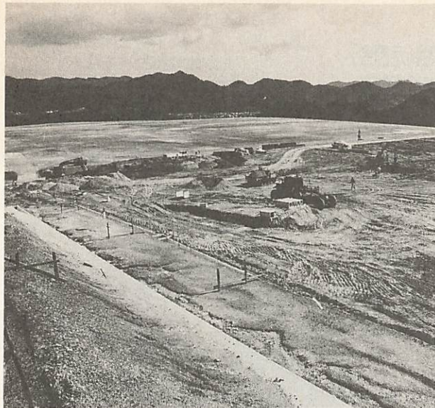
8月26日から工事が始まった(仮称)ドウ・スポーツスタジアム、市民スポーツの森建設予定地
