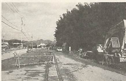
△建設中の市道御堀平井線
