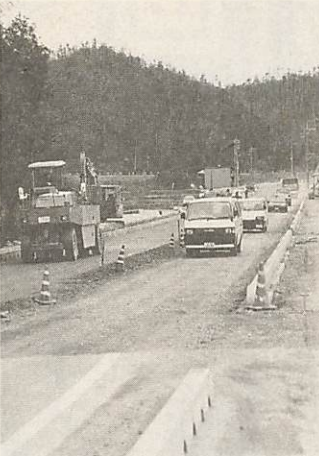
工事が進む御堀平井線
