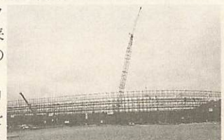
（仮称）ドゥ・スポーツスタジアム（建設中）
