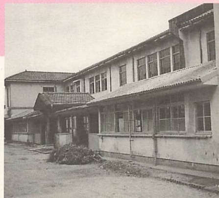
解体される旧校舎
