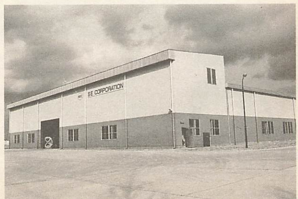
完成したエスイー（株）山口工場
