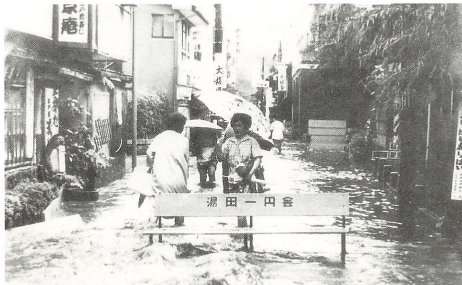
たびたび氾らんした湯田温泉の錦川は昭和45年晴きよにされた
