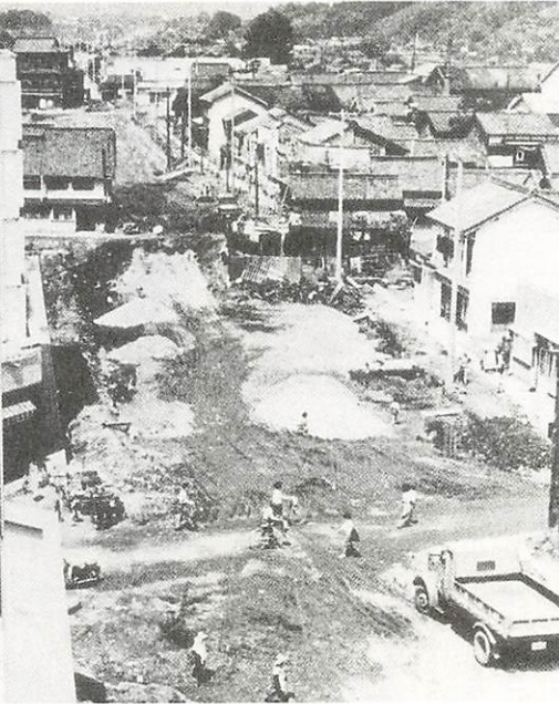
◀国道9号大改修工事 中河原の公設・川端市場付近
