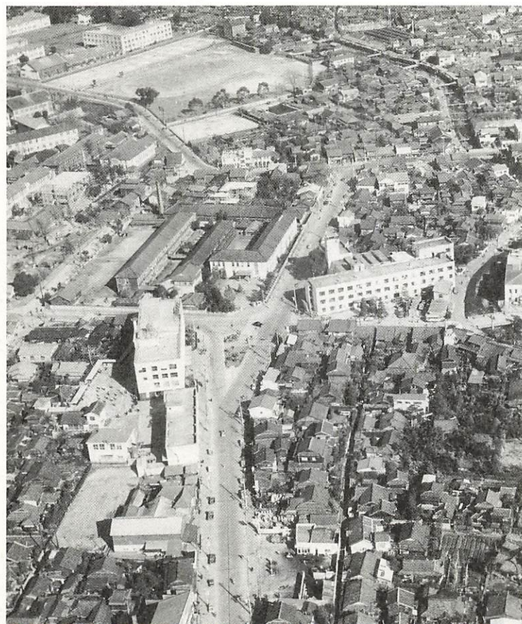
昭和36年の山口市街地。38年、国道9号（現県道204号）が市街地を貫通し、大きく様変わりした。中央右に旧市役所 —写真提供 産経新聞社—
