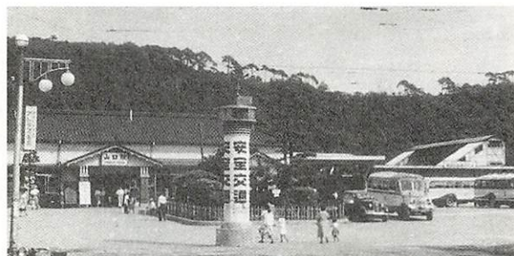
山口駅旧駅舎。昭和53年、現在の駅舎に建て替わった
