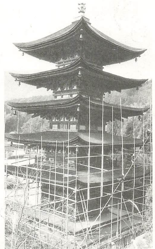
五重塔の屋根の みわた 檜皮ぶきのふき替え工事。本格的なふき替えは27年以來（昭和55年）
