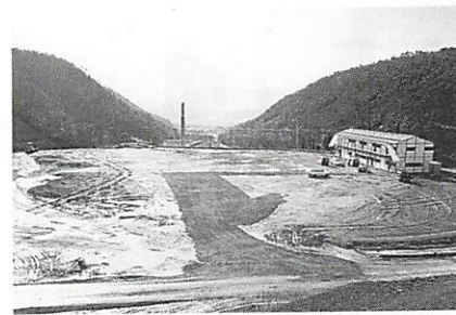
リサイクルプラザの建設地
