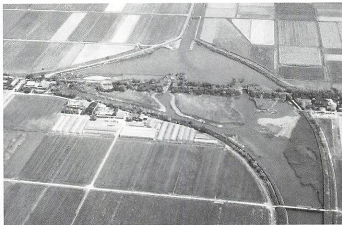
名田島新開作南蛮樋（全景）
