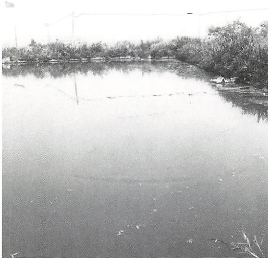
平成8年度改修工事をする平池（秋穂二島）
