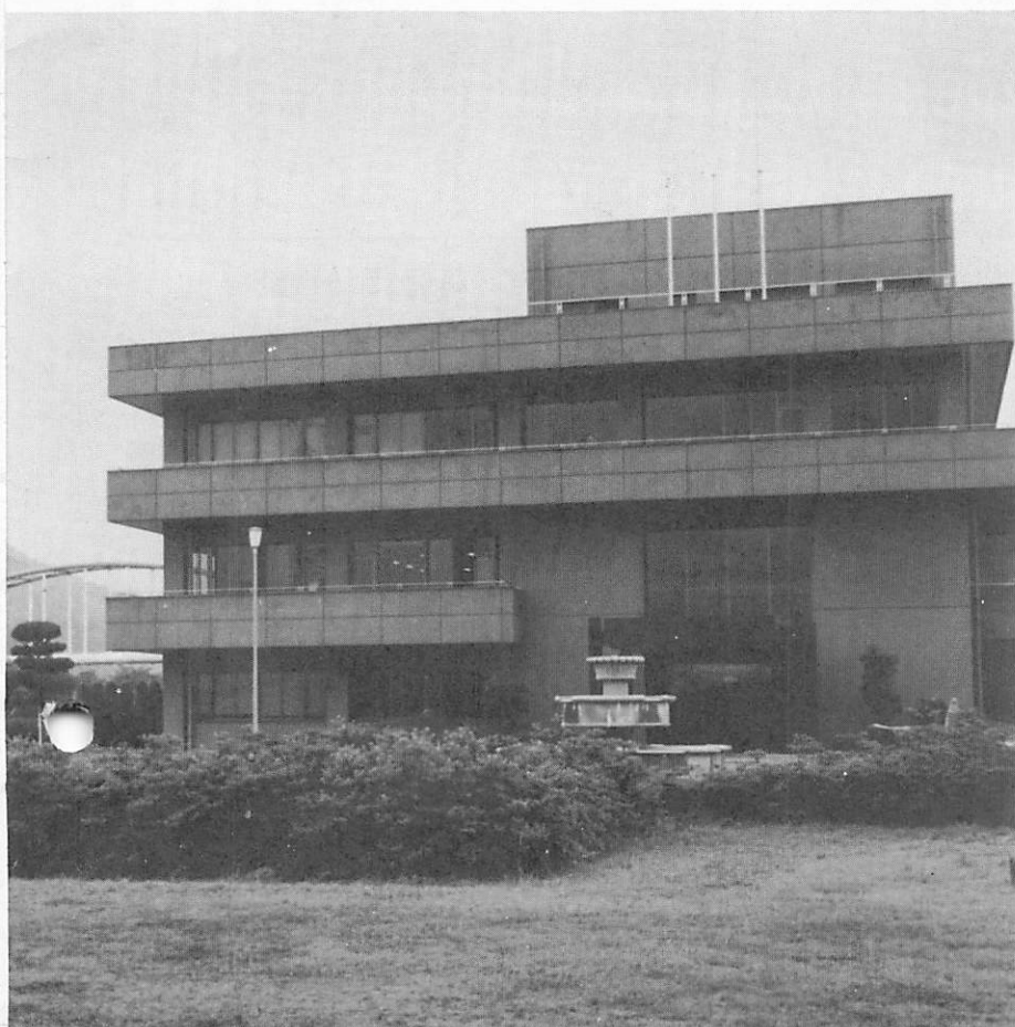
榎野川沿いにある山口・小郡地域広域水道水道企業団
