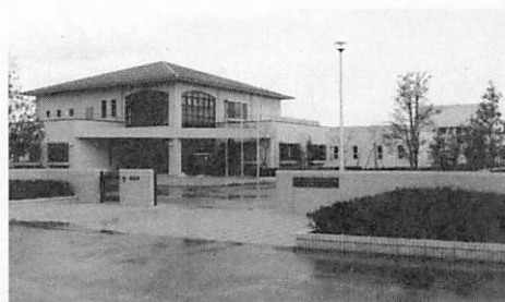
写真は「宇部・阿知須公共下水道組合浄化センター」
