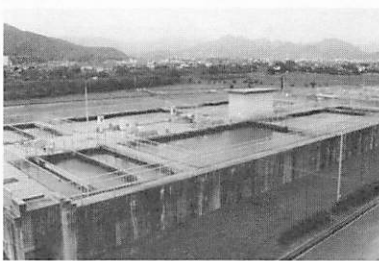
朝田浄水場の施設（山口）
