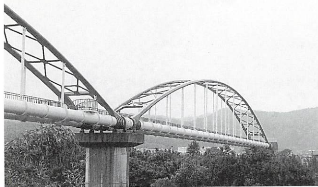
榎野川第1水管橋（朝田）
