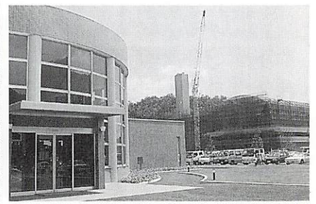
リサイクルプラザと建設中の新清掃工場
