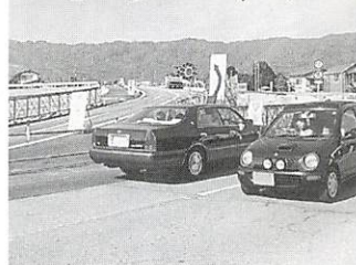
工事中の良城橋
