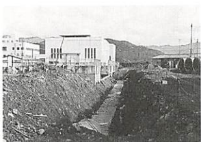
山口市浄水センターの工事風景 (昭和56年)
