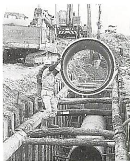
▲進む下水道工事 (昭和51年)
