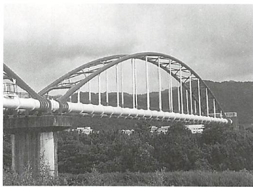
榎野川第1号水管橋
