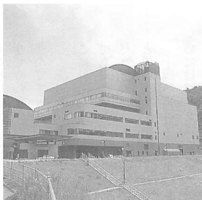
▲中部クリーンセンターが完成、より安全で効率的にごみを焼却できるようになりました（3月26日）
