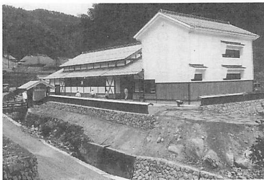
工事が進む「文化伝承館」
