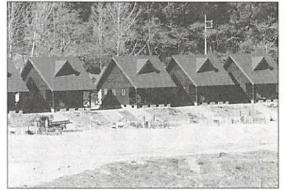
建設中のオートキャンプ場
