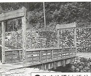
⑮ やまめ橋(木橋4) 赤木 大(堀)
