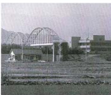
●広域水道企業団(写真右)と榎野川第1号水管橋
