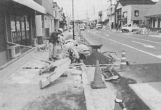
整備が進む駅通り線
