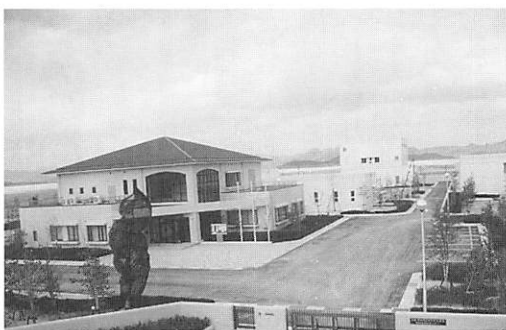
▲干拓地内にある浄化センター
