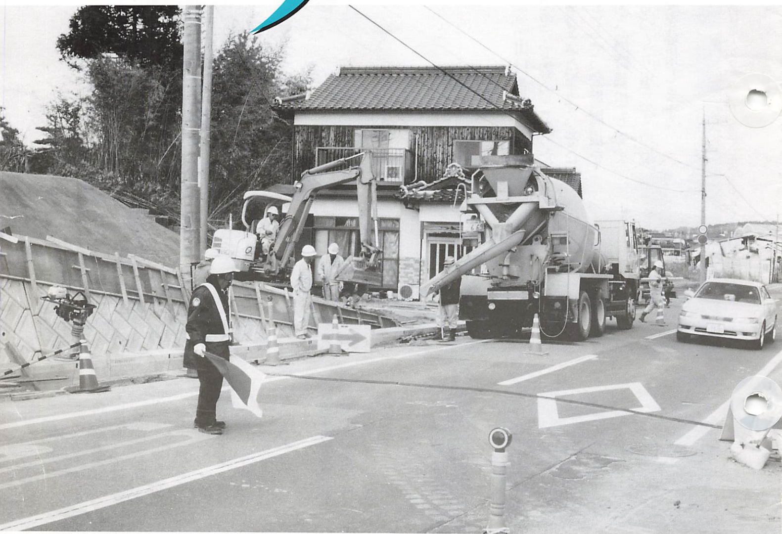
▲植松交差点（南祝・中尾漬物）付近の道路工事による交通規制の様子
