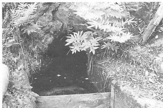
▲疎水トンネルの入口
