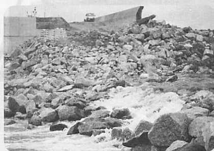
▲南工区の花浜広場の護岸開口(本年6月2日)
